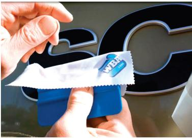
Drücken Sie mit dem Raket das überschüssige Wasser von innen zu den Seiten hin heraus, so dass keine Wasserbläschen unter dem Aufkleber zurückbleiben.
